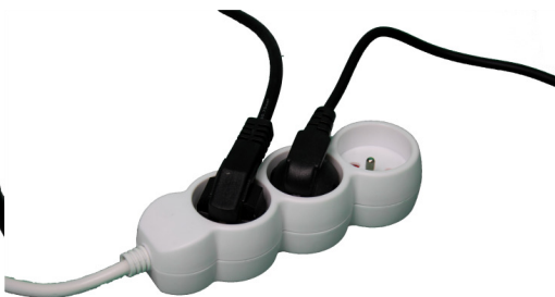
Podłączenie zasilacza projektora oraz zasilacza skrzynki komputerowej do prądu
